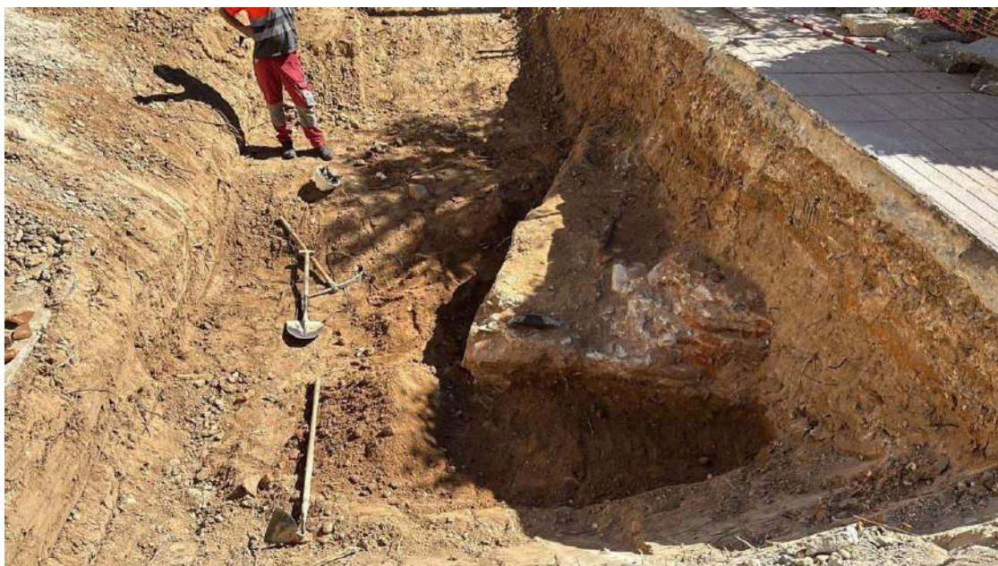
Los restos de una esquina aparecidos durante la obra de la avenida de Huelva. / LA CRÓNICA DE BADAJOZ
