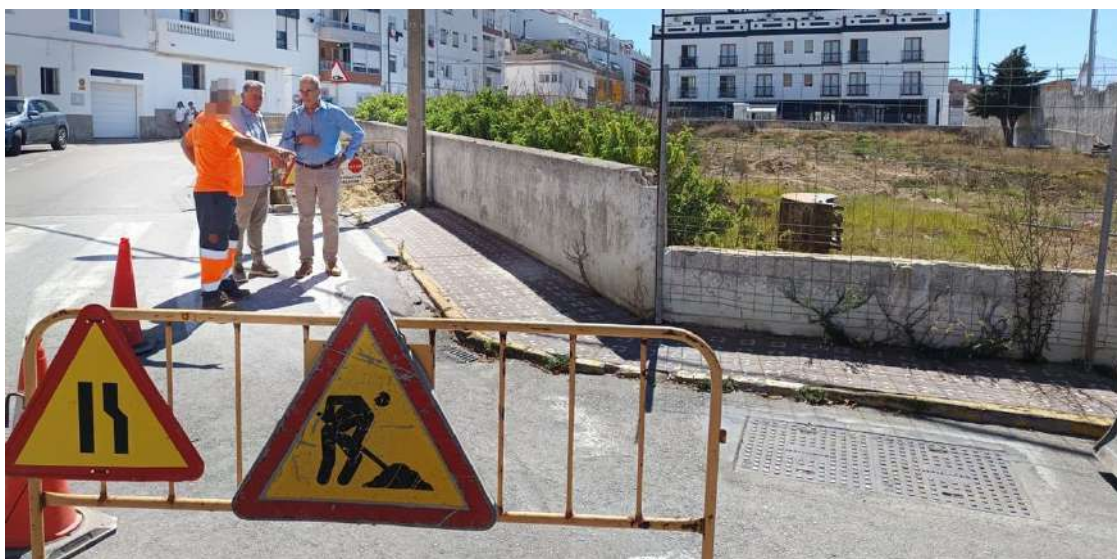
El alcalde y el segundo teniente de alcalde visitando las últimas obras aparejadas a la futura construcción de las 59 viviendas de VPO/TAD
