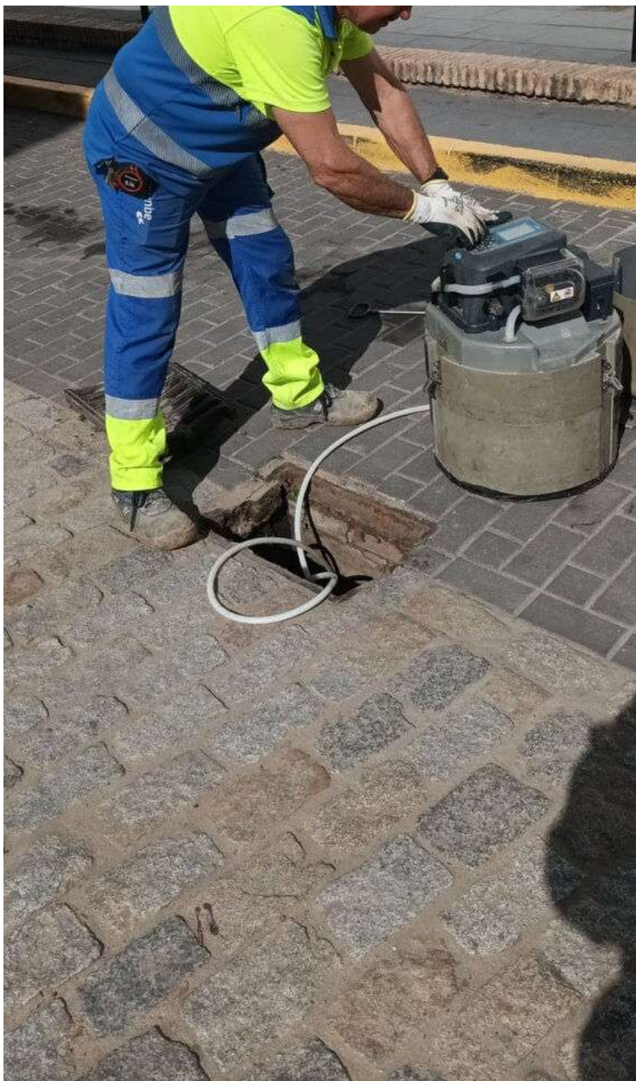
Un operario de Aqualia controlando posibles vertidos. | Viva
