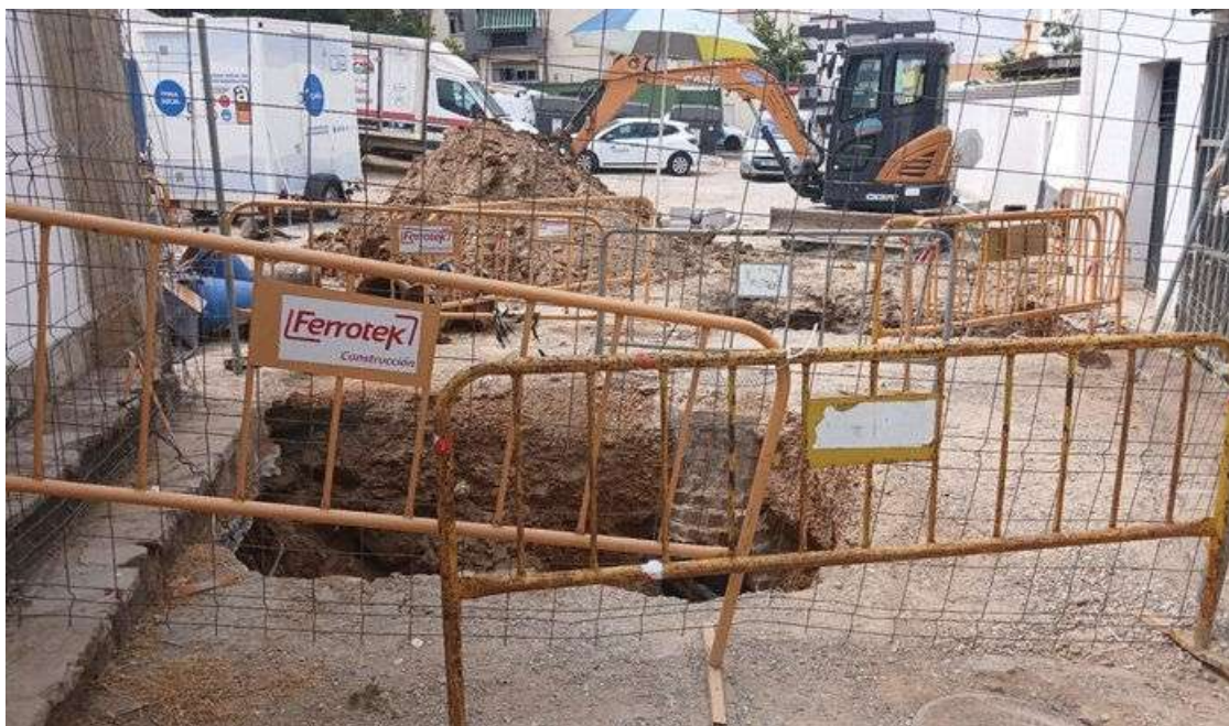
Trabajos en la zona. / FOTO: AAM
